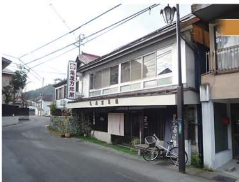
▲米沢 亀屋万年閣 改修前外観
