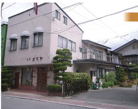
▲諏訪 小島いつ邸 改修前外観
