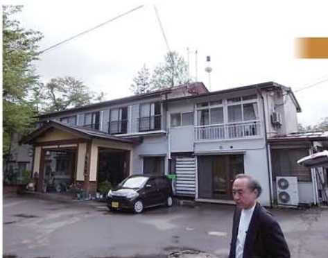
▲新潟 しなの荘 改修前外観
